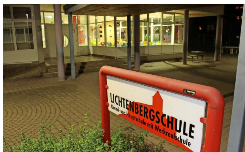
Den Kosten von 37 000 Euro für einen ebenerdigen Zugang an dieser Stelle verweigerte der Gemeinderat seine Zustimmung.
